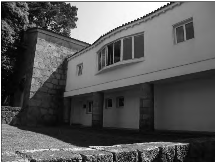
Soportal sobre cilindros de cantaría.
